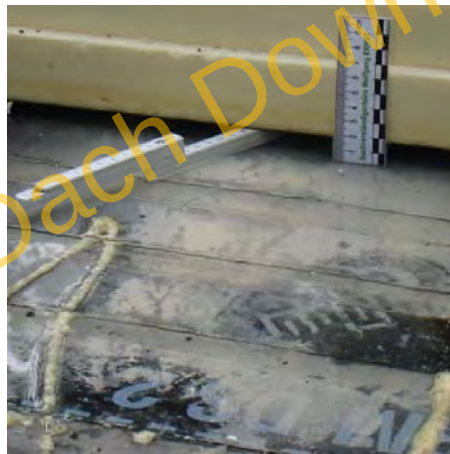
Abbildung 05: Hohlraum unter der Wärmedämmung durch PU-Kleberauppen.
