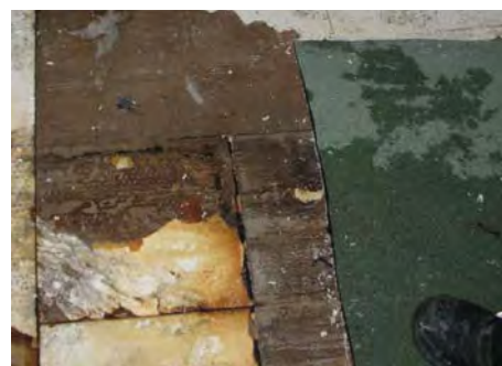
Abbildung 09: Durch jahrelange Feuchtigkeitseinwirkung zerstörte PUR-Dämmplatte.
