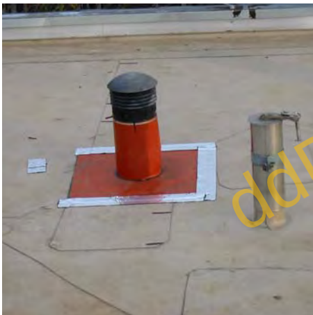
Abbildungen 02, 03: Rohrstutzen zur Wasserabsaugung mit einer PVC-Bahn auf eine TPO-Bahn mangelhaft "aufgeklebt", gleich daneben eine mechanische Beschädigung.
