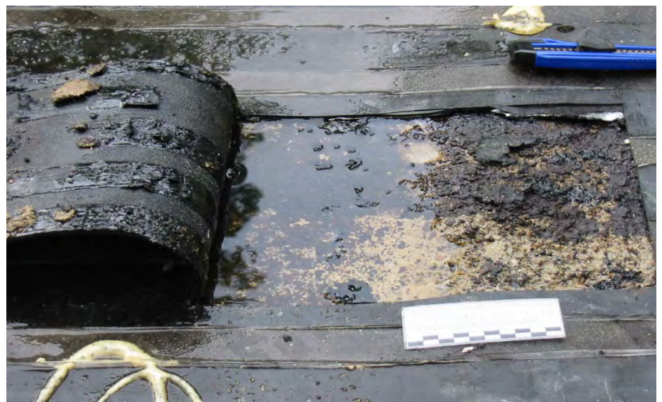
Abbildung 05: Hohlraum unter der Wärmedämmung durch PU-Kleberauppen.
