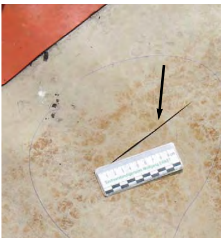
Abbildungen 02, 03: Rohrstutzen zur Wasserabsaugung mit einer PVC-Bahn auf eine TPO-Bahn mangelhaft "aufgeklebt", gleich daneben eine mechanische Beschädigung.
