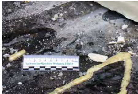
Abbildung 04: PU-Kleberauppen wirken wie partielle Abschnügelungen.
