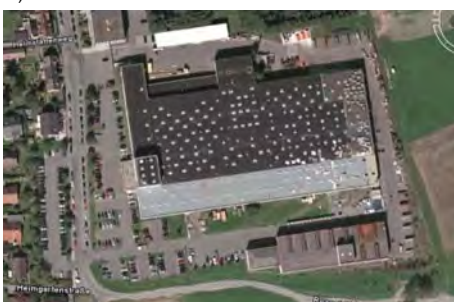
A) Industriebau mit ca. 10.000 m 2 Dachfläche
