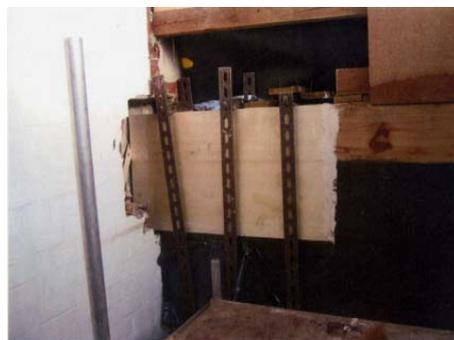
Eine vor Jahren erfolgte Sanierung mit PU-Schaum auf der undichten Bitumenabdichtung war nicht dauerhaft. Der PU-Schaum war komplett durchfeuchtet. Das eingedrungene Wasser hat sich auf der alten Bitumenabdichtung gesammelt und ist in den An- und Abschlussbereichen in die Konstruktion eingedrungen. Der komplette Aufbau musste bis zur Holzschalung entfernt werden.
