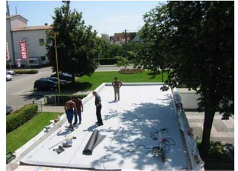
Die Überprüfung der Statik ergab eine geringere Belastung als angenommen, so dass mit einer Gefälledämmung und einer frei bewitterten Kunststoffbahn schon die Obergrenzen der Lasten erreicht wurden. Eine ursprünglich vorgesehene Extensivbegrüpfung der Dachflächen war somit nicht zu realisieren.
