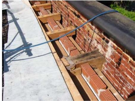
Aufgrund der sichtbaren Feuchteschäden an der Holzkonstruktion wurden alle tragenden Balken/Holzleimbinder im Auflagerbereich für eine Feuchtigkeitsmessung freigelegt und ein Feuchtemessprotokoll angefertigt.
