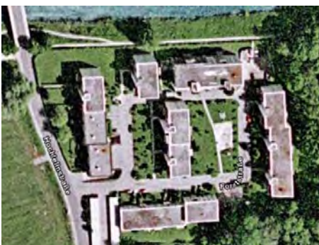
Abbildung 5: C) Wohnungseigentümergelegenheit mit ca. 4.500 m 2 Dachfläche
