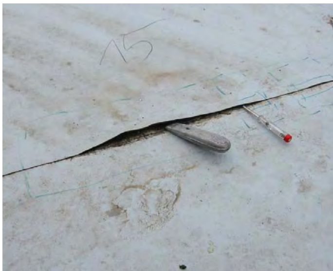
Abbildung 6: Objekt D) Mangelstellen bei der Automatschweißnaht.
