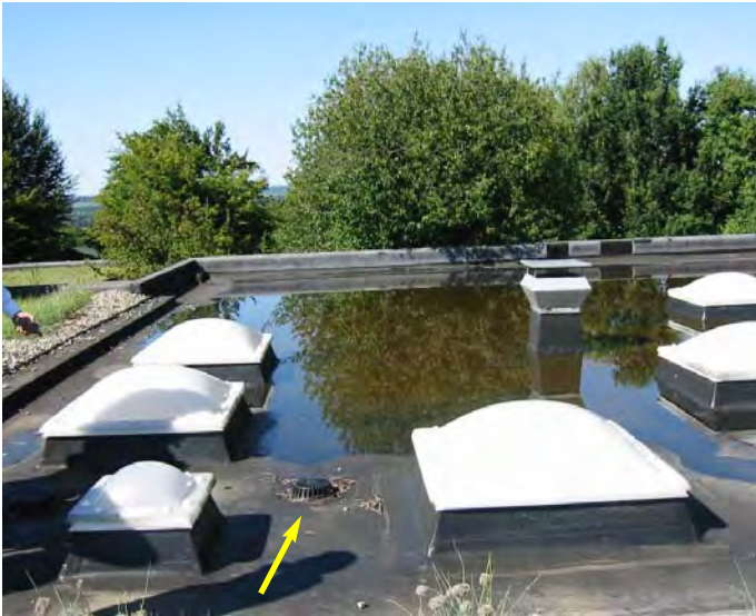
Abbildung 9: Objekt D) Dachabläufe am Hochpunkt, stehendes Wasser auf der Dachfläche.
