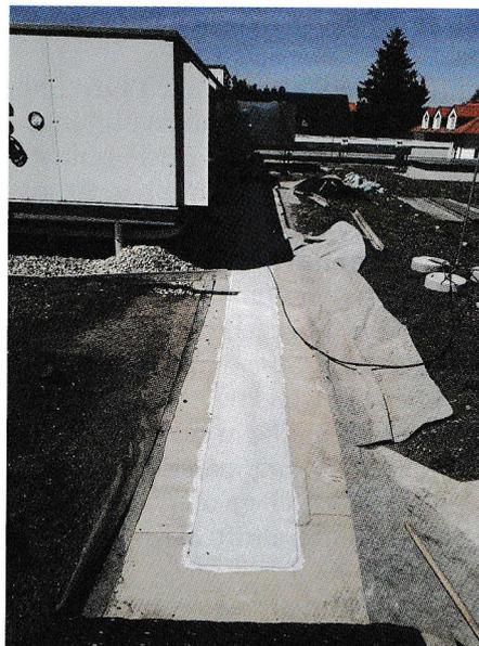
**Bild 7.** Überschweißung der gesamten mangelhaft ausgeführten Naht als notwendige Nachbesserungsmaßnahme
