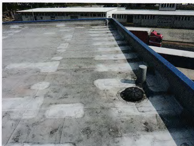
Bild 4. Industriedach nach erfolgreicher Mängelbeseitigung (RPZ 30) – keine besonderen Anforderungen an Qualität und Ausführung, Ausschreibung nach Mindestanforderungen, Billigpreisvergabe, Undichtigkeiten noch vor der Abnahme, Verweigerung der Nachbesserung vom GU; vom Bauherrn veranlasst: technische Abnahme durch externe Flachdachexperten mit ausführlichem Mängelprotokoll/ Gutachten, gerichtliche Beweissicherung, danach umfangreiche Mängelbeseitigung gemäß richterlichem Beschluss mit technischer Abnahme (Zustandsfeststellung)
