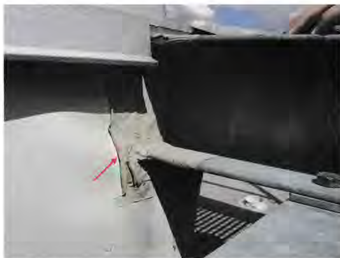
Bild 1. Nicht fachgerechte Anwendung des „Nichtplanungshilfsmittels“ Flüssigkunststoff
