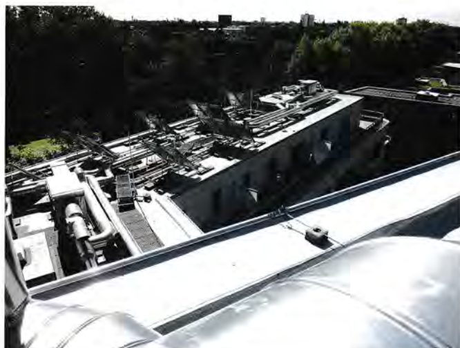
Bild 6. Flachdach mit zusätzlich hoher mechanischer Beanspruchung durch Lüftungsinstalltionen und PV-Anlage (Fotos 1, 3–6: Wolfgang Ernst)
