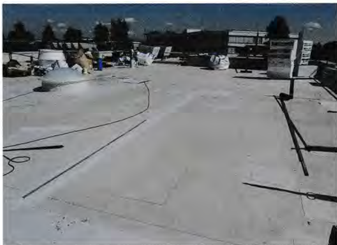
Bild 3. Risikodach mit eingeschränkter Nutzungsdauer (RPZ 250) – keine besonderen Anforderungen an Qualität und Ausführung, Ausschreibung nach Mindestanforderungen, Billigstpreisvergabe, Ausführung mit (ausländischen) Subunternehmern, keine Abnahme der Abdichtung vor dem Aufbringen der Begrünung: ständige Nachbesserungen infolge temporärer Undichtigkeiten, Komplettsanierung nach 16 Jahren, Schadensursache: mangelhafte Ausführung
