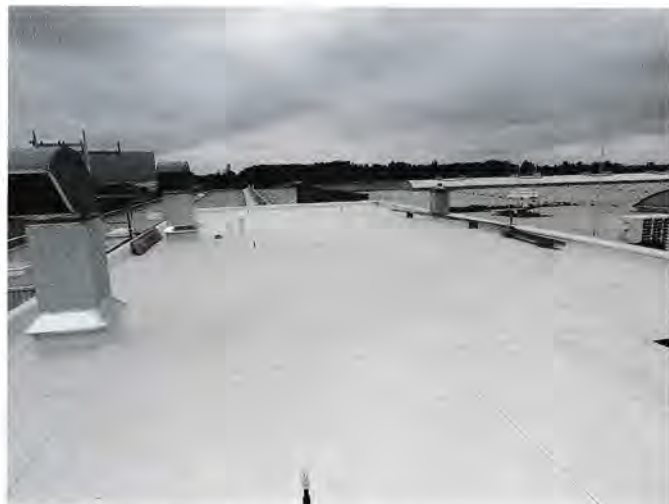
Bild 5. Verwaltungsgebäude (RPZ 1) – durchgehende Betreuung durch Sachverständigen, nach den Qualitätsanforderungen des ddD e. V. ausgeführte Dachfläche mit „sehr gut“ bewerteter Dachbahn, ausführende Firma mit ddD-Qualitätslabel – Verarbeitung, prognostizierte Nutzungsdauer > 50 Jahre
