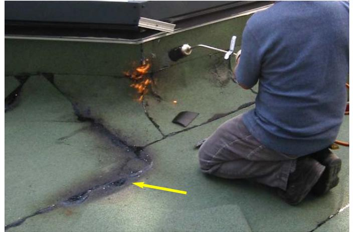
Abb. 04: Zorniges Abflämmen der Nahtverbindungen nach Beanstandungen bei der Abnahme. Dabei wurde die gesamte Struktur der Bitumenoberlagsbahn inkl. Trägereinlage zerstört.
