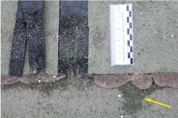
Abb. 01: Durch Kapillarität zwischen die Lagen eingezogenes Wasser tritt in der Abtrocknungsphase sichtbar aus.
